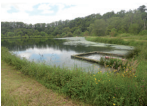
Assainissement : curage de la lagune
