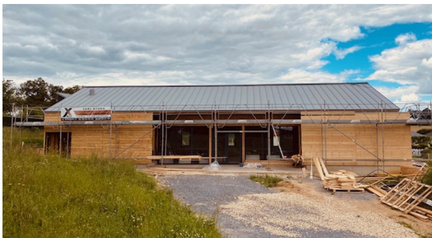
Ci-contre : La MAM en construction.
